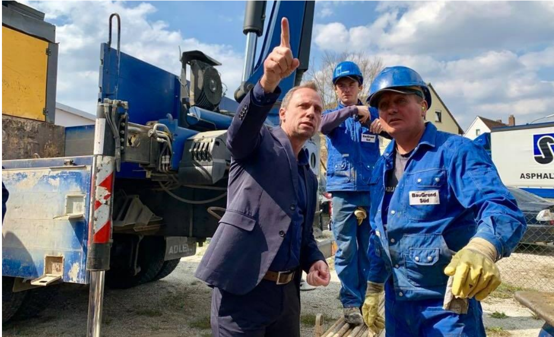
„Live-Bohrung“ der Erdwärme Gemeinschaft Bayern e. V. mit Umweltminister Glauber
