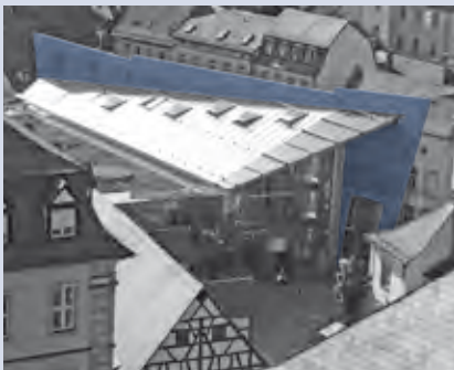
Hinter der Betonmauer (blau) beginnt der zweite Bauabschnitt der TB4
