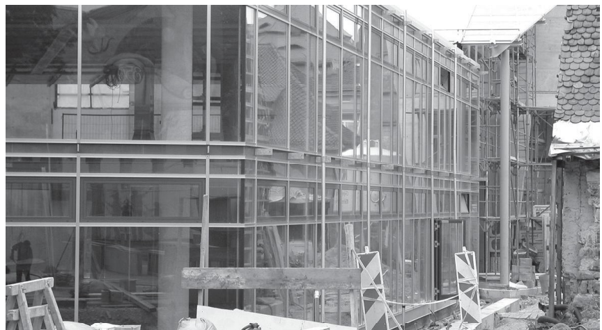
Baustelle der TB 4 am 30. Juni 2003
