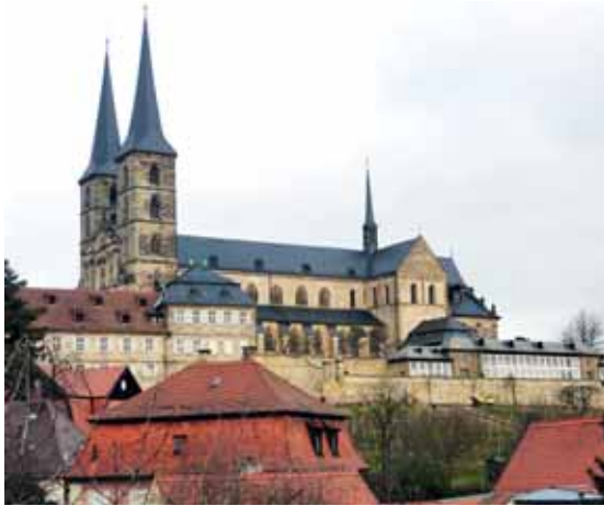
Blick von Südwesten auf die Kirche St. Michael, den Südflügel der Abteigebäude, die Orangerie und den Weinberg.
